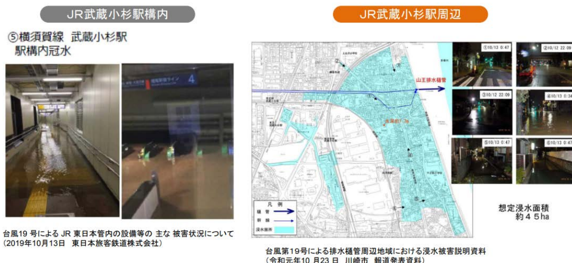
図 武蔵小杉駅構内・周辺での浸水被害
