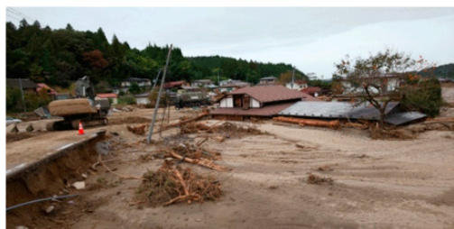
宮城県（丸森町）の土砂被害
