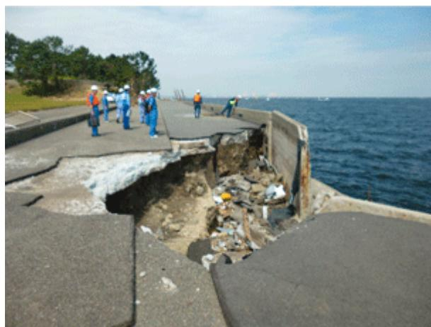
図 横浜市金沢地区 護岸の被災状況
