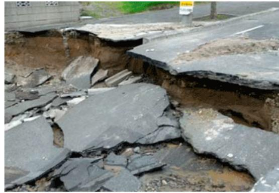
水道管が破裂し浸水（札幌市清田区）
