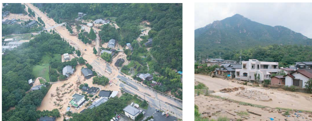
図 防府市の被害状況
