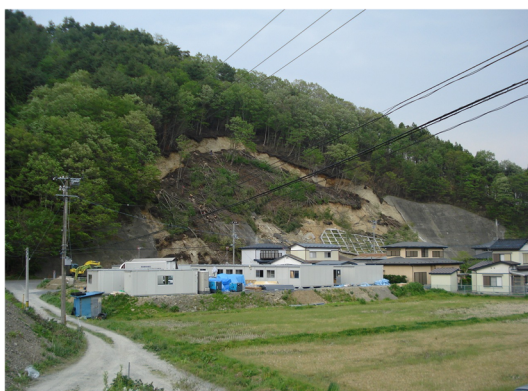
一級町道小槌線（法面崩壊）
