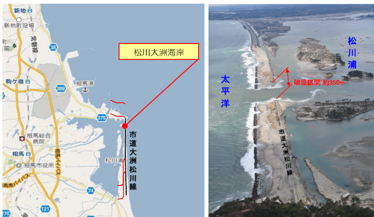
図 市道大洲松川線の位置及び被害状況（平成 23 年 4 月時点）
