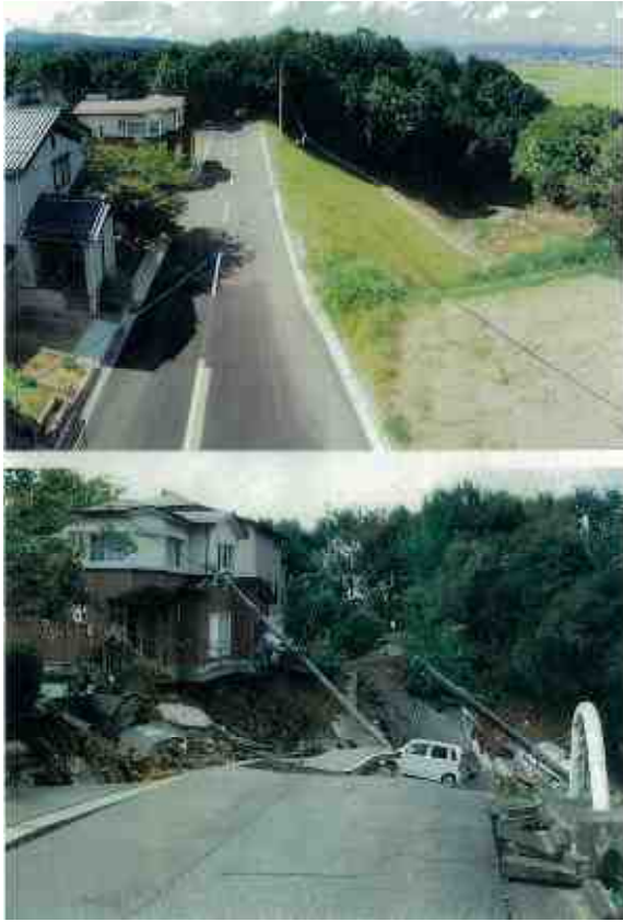
写真1 被害と復旧の状況 6)
