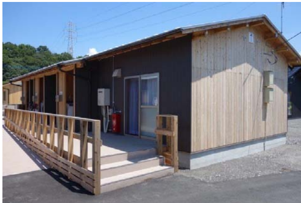
木造仮設①【宇城市当尾団地】(30戸)
