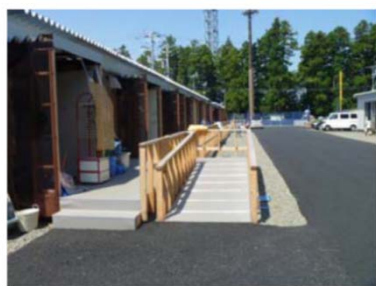
住戸前の舗装、スロープの設置
