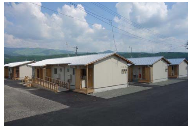
木造仮設②【西原村小森第1団地】(30戸)
