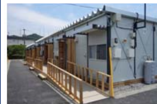
■玄関スロープや玄関の木の袖壁
