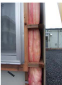
追加工事による 外断熱
