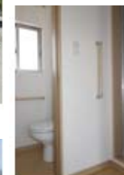
■玄関・トイレ・浴室の手すり
