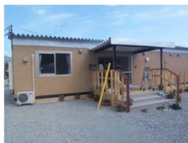
グループホーム型仮設住宅
