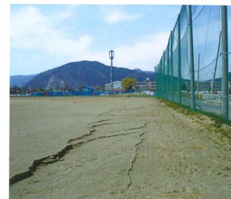
■建設候補地に地割れ【石巻市】
