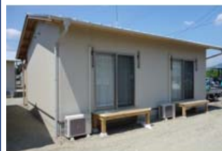
■掃出し窓、濡れ縁
