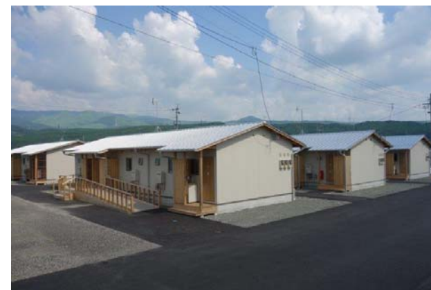
木造仮設②【西原村小森第1団地】(30戸)
