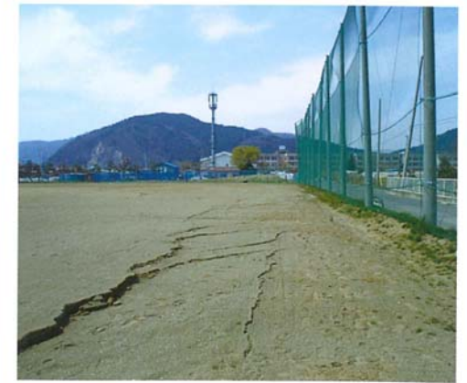
■建設候補地に地割れ【石巻市】
