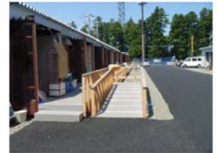
住戸前の舗装、スロープの設置
