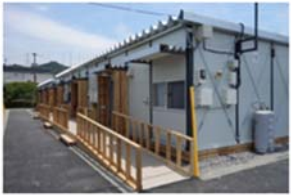
■玄関スロープや玄関の木の袖壁
