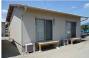
■掃出し窓、濡れ縁
