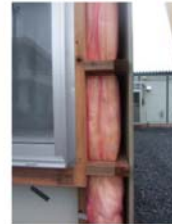
追加工事による 外断熱
