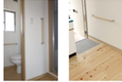
■玄関・トイレ・浴室の手すり
