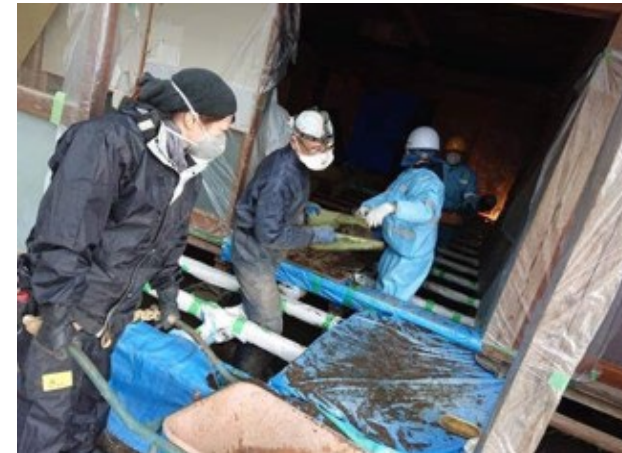
床下の泥の撤去 (宮城県丸森町)
