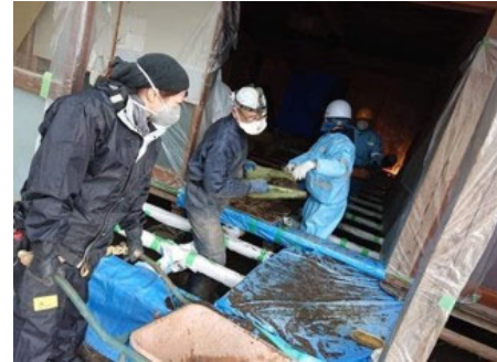
床下の泥の撤去 (宮城県丸森町)
