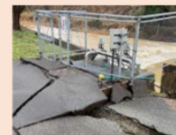
水道の復旧 (被災した浄水場)
