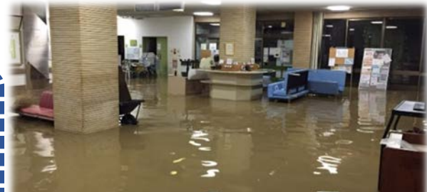
きぬ医師会病院の浸水状況 (提供：きぬ医師会病院)
