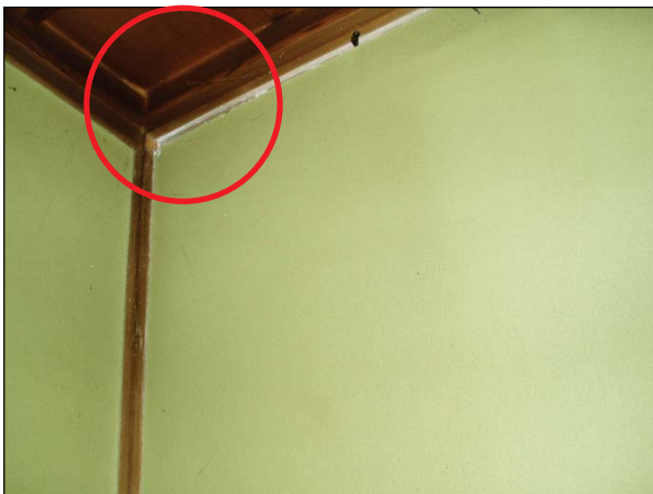
内壁周辺部に隙間が生じている。
