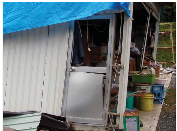
【アルミドア】 破壊されている。
