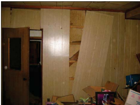
内壁合板に剥離、脱落が見られる。
