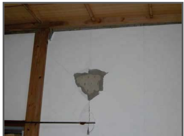
衝突等によりクロスが破れている
