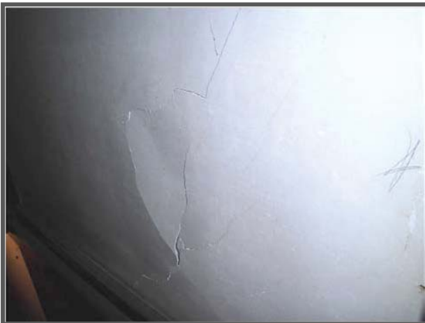
衝突によりへこみが生じている
