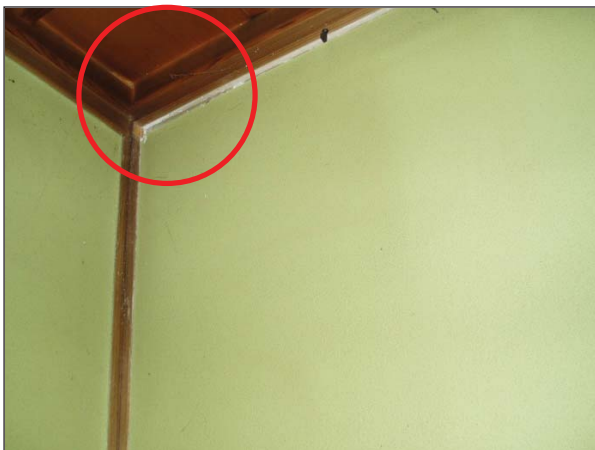
内壁周辺部に隙間が生じている。
