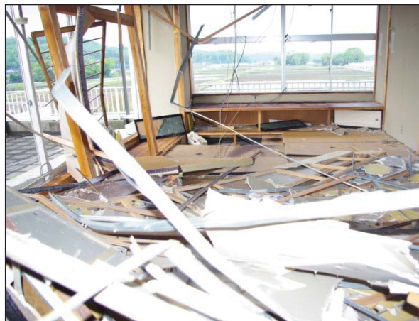
【アルミサッシ、木製サッシ】 枠ごと外れて破壊されている。
