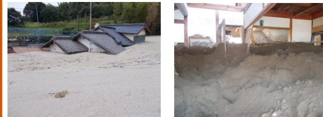
<平成29年九州北部豪雨での土砂堆積等による住家被害の例>
