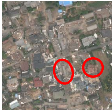
<平成28年熊本地震 被災後（2016年4月16日撮影）>
