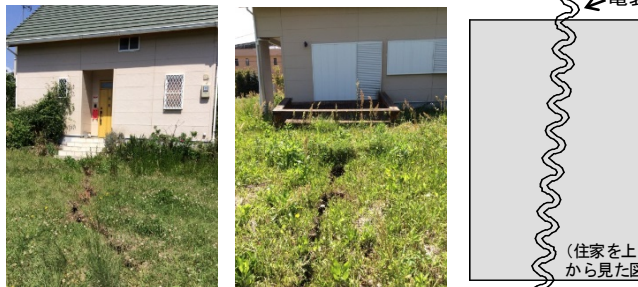
<平成28年熊本地震での亀裂による住家被害の例と「全壊」と判定される亀裂のイメージ>
