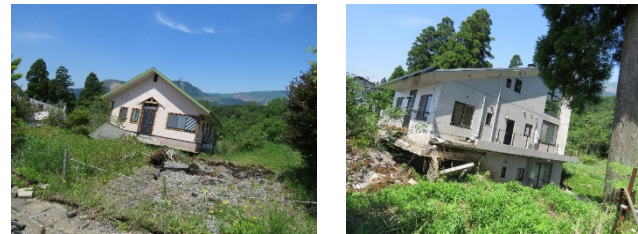
<平成28年熊本地震での斜面崩壊による住家被害の例>
