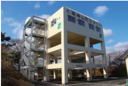
津波避難タワー
