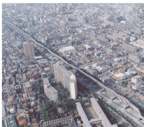
阪神高速の高架道路の倒壊 出典：国土交通省 近畿地方整備局
