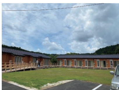
木造による仮設団地
