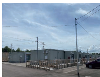
プレハブ型の応急仮設住宅
