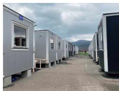
ムービングハウス型の応急仮設住宅
