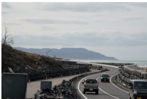
隆起海岸を活用した迂回路の様子（国道249号白米千枚田付近）
