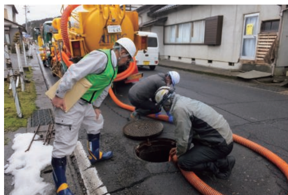
MAFF-SATによる 農業集落排水施設の点検（能登町） 出典：農林水産省
