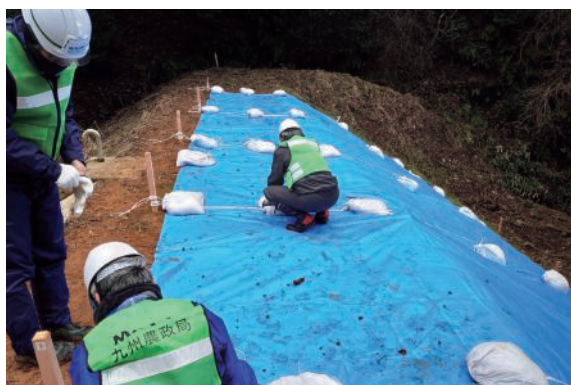
MAFF-SATによる被災ため池における ブルーシートの設置（志賀町） 出典：農林水産省
