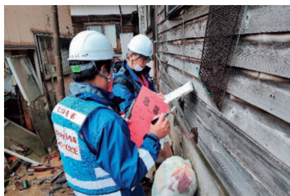
TEC-FORCEによる判定ステッカーの 記入・貼付（穴水町） 出典：国土交通省
