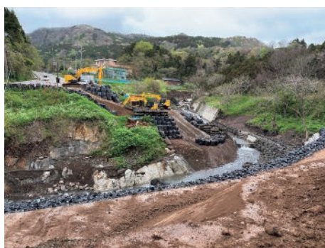
権限代行による地すべり防止工事の様子（石川県輪島市）
