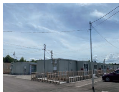
プレハブ型の応急仮設住宅
