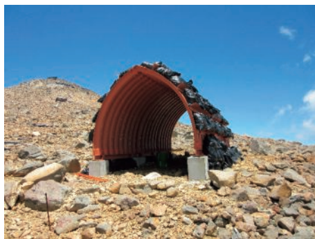
御嶽山に設置された避難施設（王滝村）
