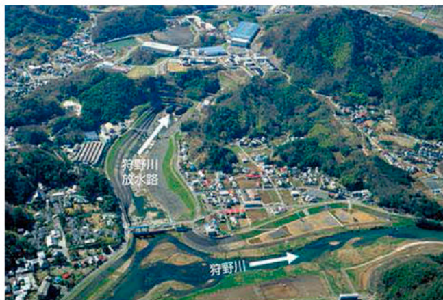
写真8 狩野川放水路
