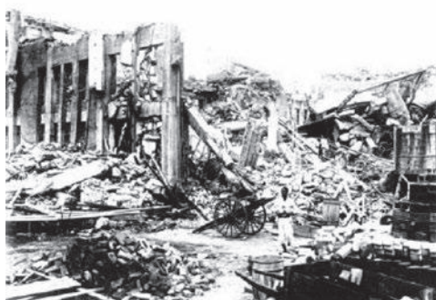
内外ビル (建設工事中に崩壊)
