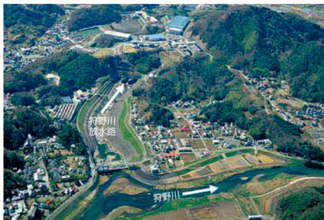
写真8 狩野川放水路
