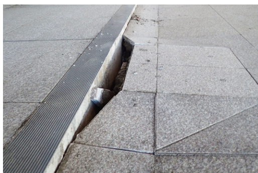
路面のひび割れ（福島県相馬市）
