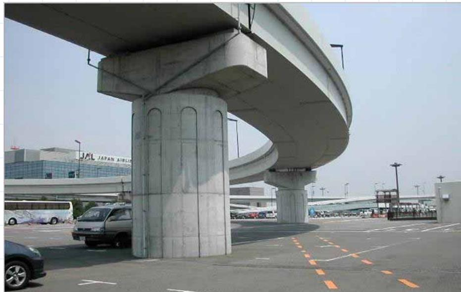
コンクリート橋脚の補強事例(コンクリート巻立)
