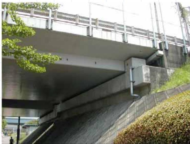
コンクリート桁の事例（桁座拡幅）
