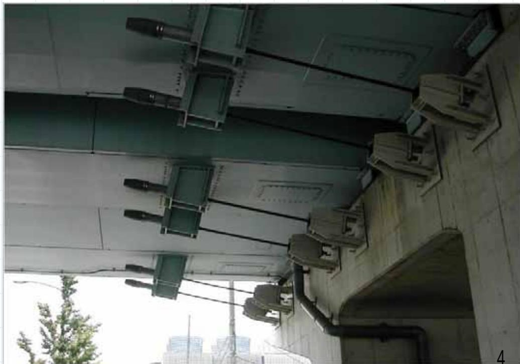
鋼製桁の事例（桁連結工）
