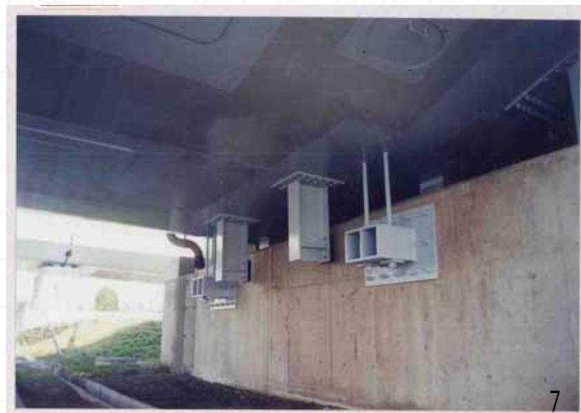
鋼製桁の事例(変位制限装置)
