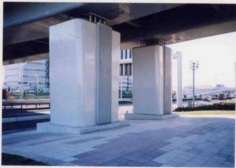
コンクリート橋脚の補強事例(鋼板巻立)
