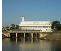
南畑排水機場
