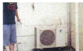
浸水被害の状況
