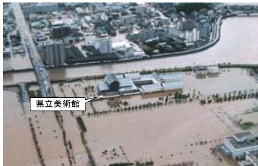
写真3 高知県立美術館浸水状況(高知県撮影)
