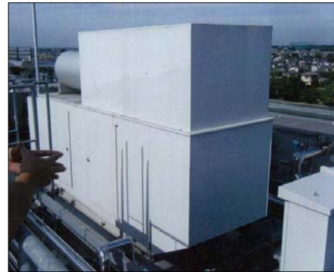
屋上に設置された非常用発電機
