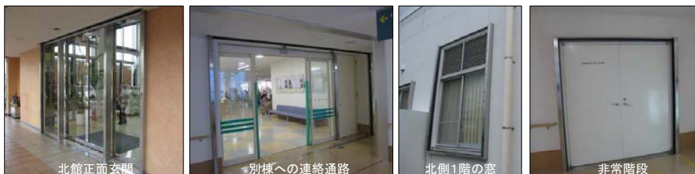
止水板のための角落し設置
