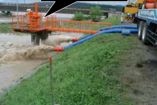
樋門の操作場所
