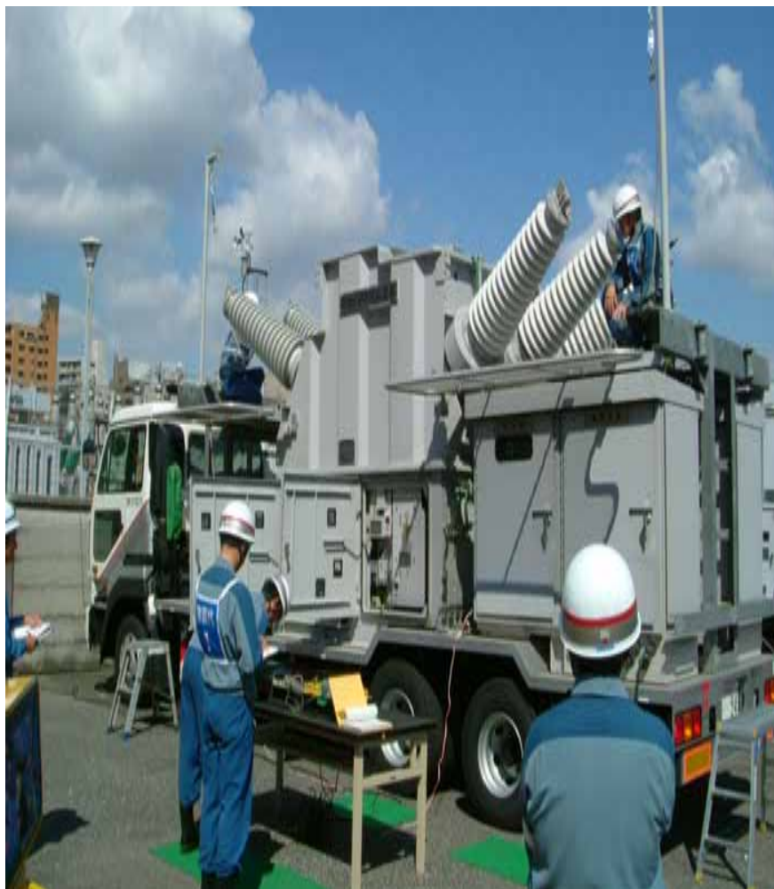
送変電設備復旧訓練状況
