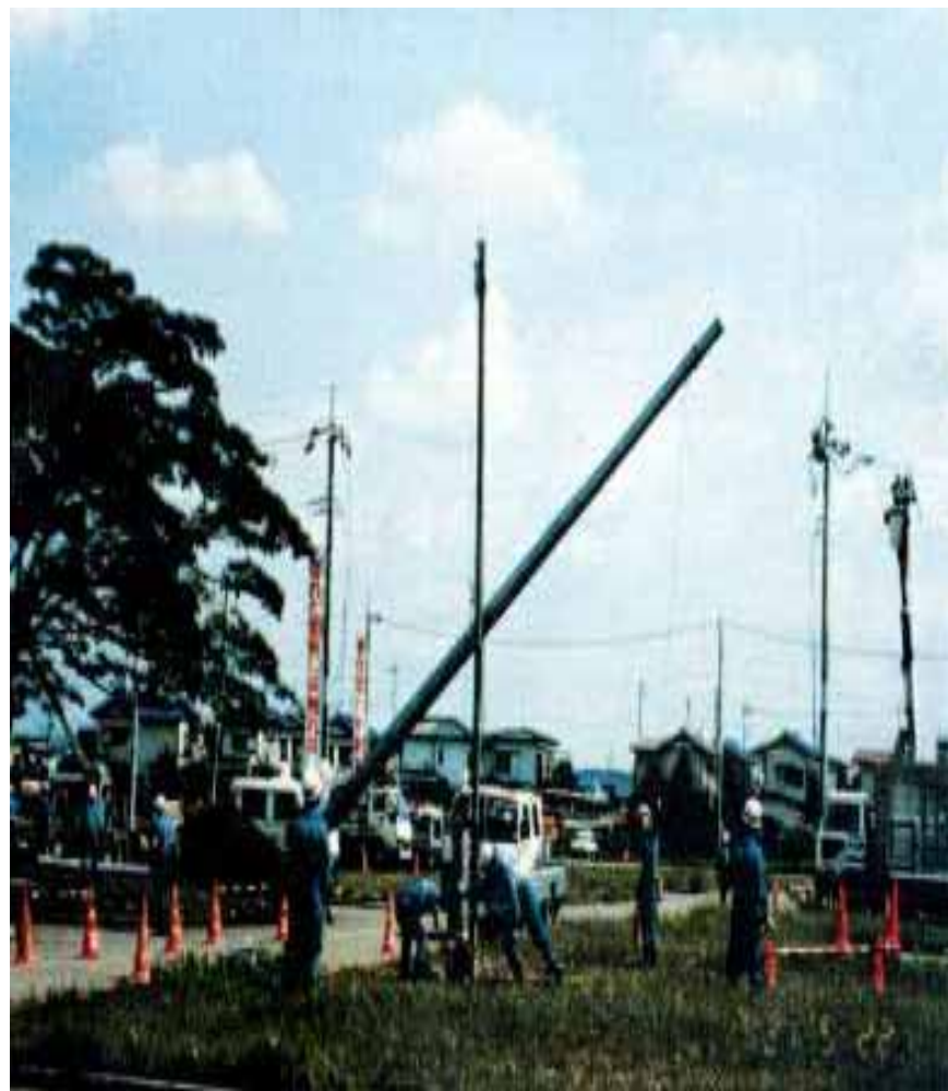
配電設備復旧訓練状況
