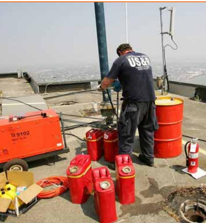
通信施設の発電機への燃料補給 (FEMAのHPより)
