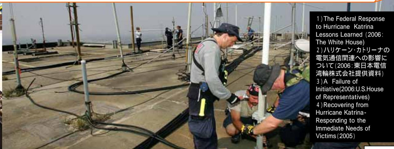
通信が途絶したため、双方向無線通信システムの据付を実施(FEMAのHPより)
