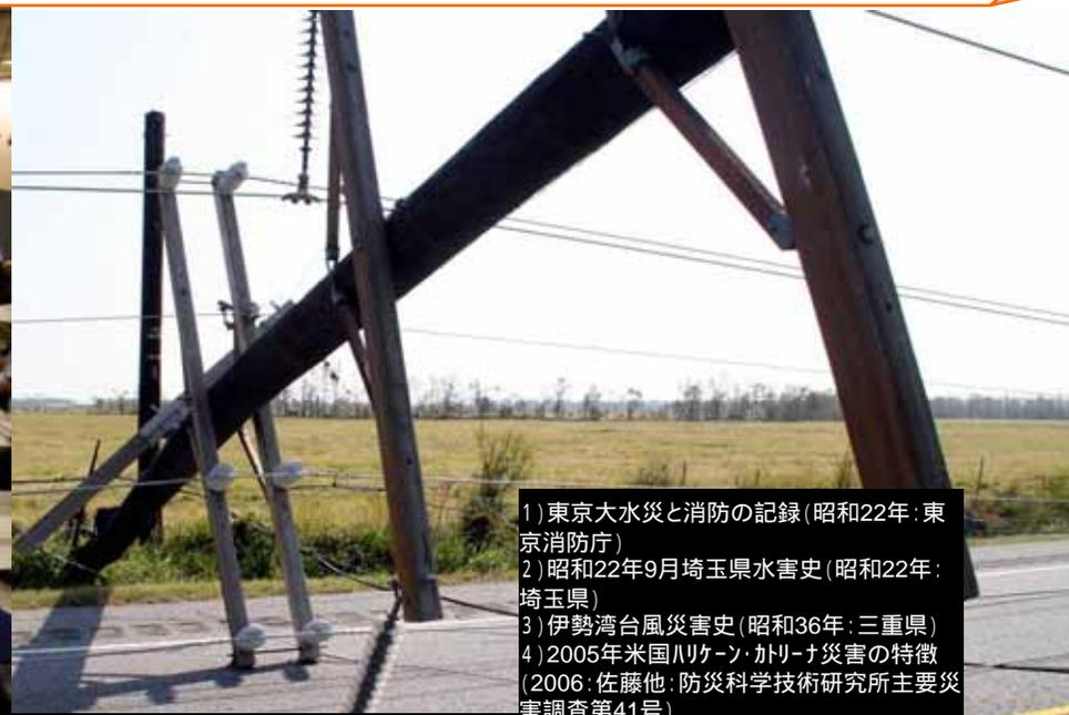
電柱倒壊による電線・通信線寸断 (FEMAのHPより)
