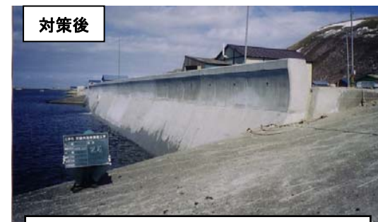
前腹付けによる老朽化対策後の護岸
