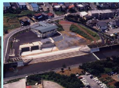
(恩廻公園調節池)
