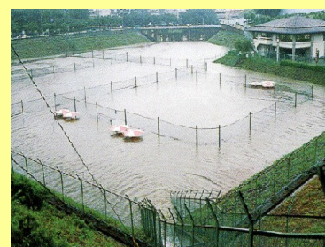
(霧が丘調整池)
