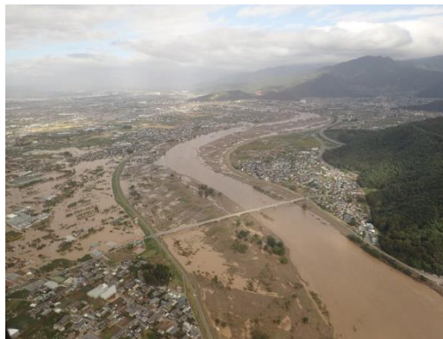
長野県長野市 被災状況
