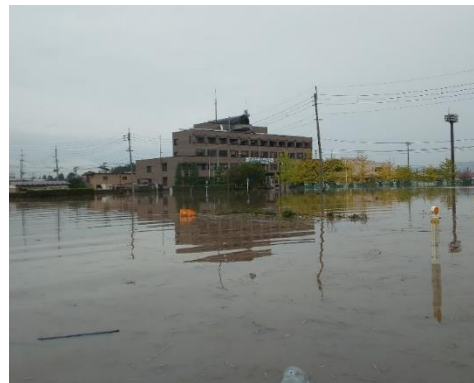
宮城県丸森町 被災状況
