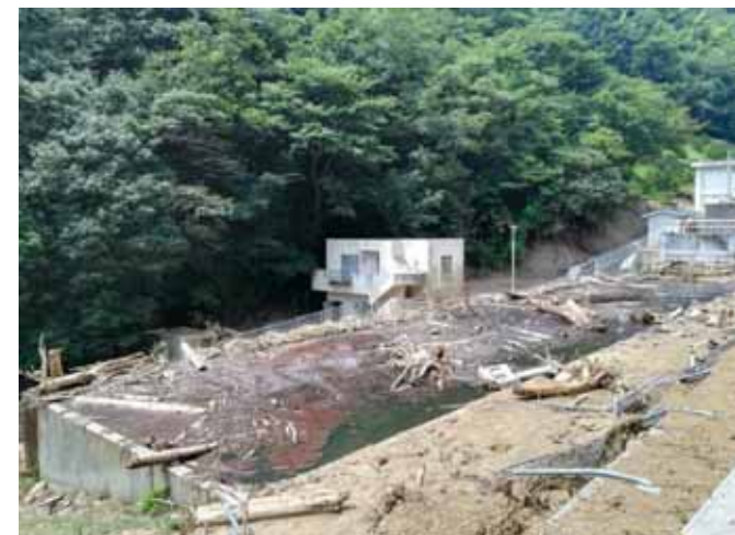
浄水場の被害 (愛媛県宇和島市 吉田浄水場)
