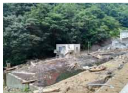
浄水場の被害状況 (愛媛県宇和島市 吉田浄水場)
