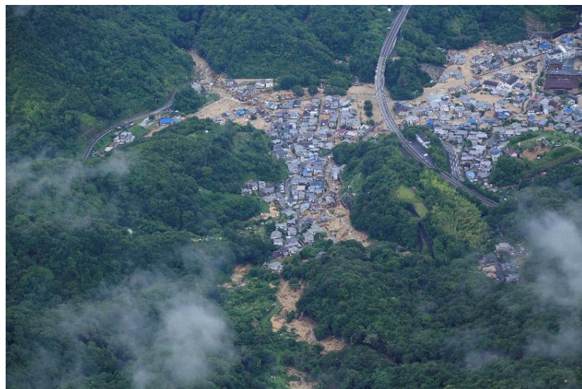
【被災状況】広島県安芸郡坂町小屋浦周辺 提供：広島県
