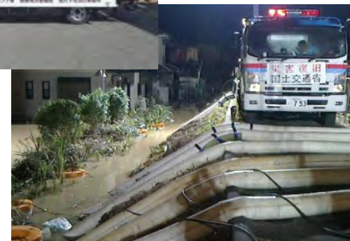
写真上：国土交通省が所有する排水ポンプ車 写真下：排水作業状況 (H27.9)
