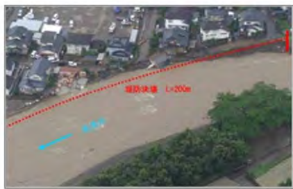
浸食により家屋が流失した状況
