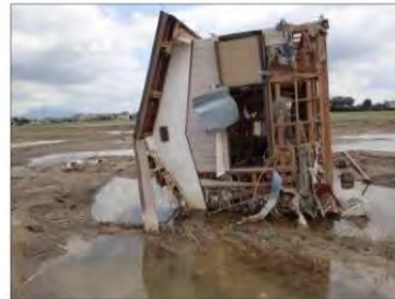
堤防決壊による家屋の倒壊
