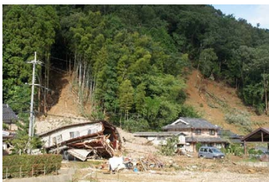
図17 被災箇所（丹波市徳尾地区） （丹波市提供）
