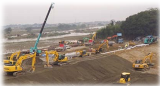
写真 13 国土交通省による堤防の応急復旧
