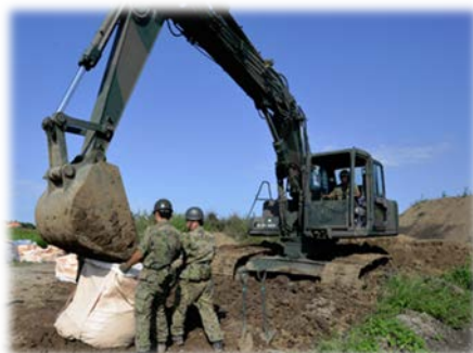
写真 15、16 自衛隊による水防活動（土のう積み）
