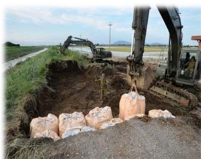
写真 15、16 自衛隊による水防活動（土のう積み）
