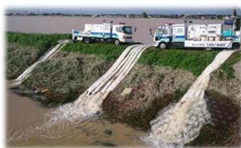
写真 14 国土交通省による氾濫水の排水
