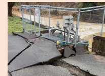
水道の復旧 (被災した浄水場)
