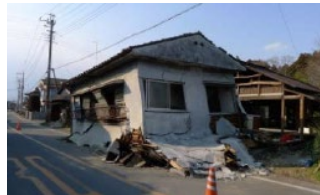
揺れによる被害
