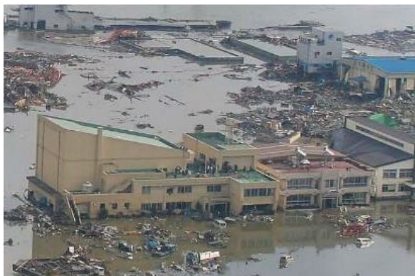
津波による被害
