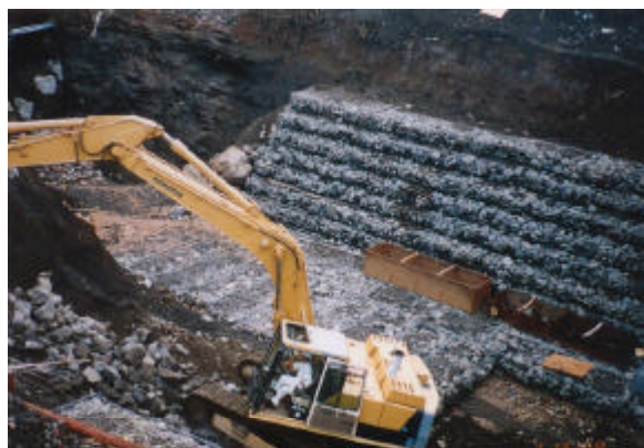
人家の被害拡大を防止するための泥流対策
