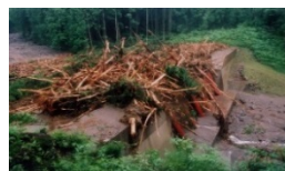
流木捕捉式治山ダムの設置
