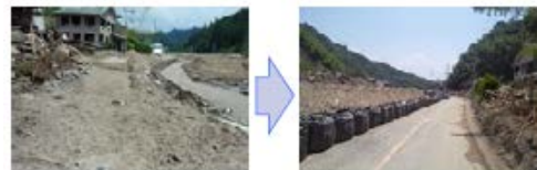
道路啓開の実施
