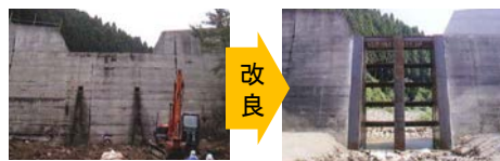
透過型砂防堰堤への改良
