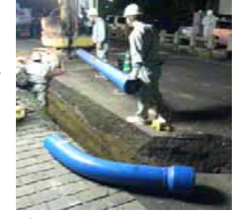
ポリエチレン管の布設
