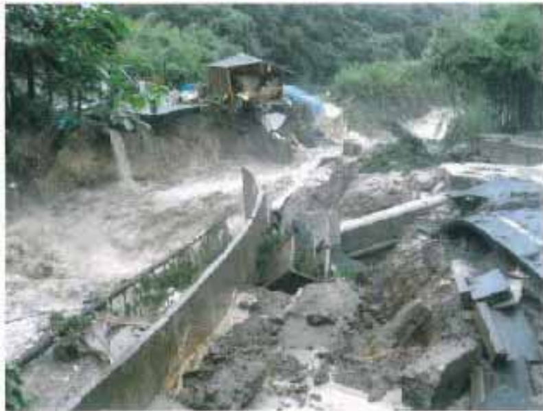
平成18年7月豪雨の大口市の被災状況
