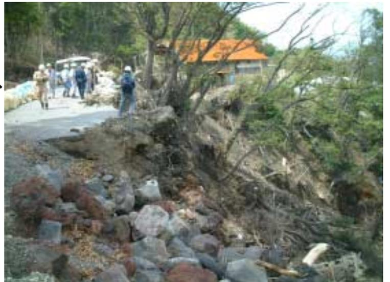
泥流により崩壊した林道
