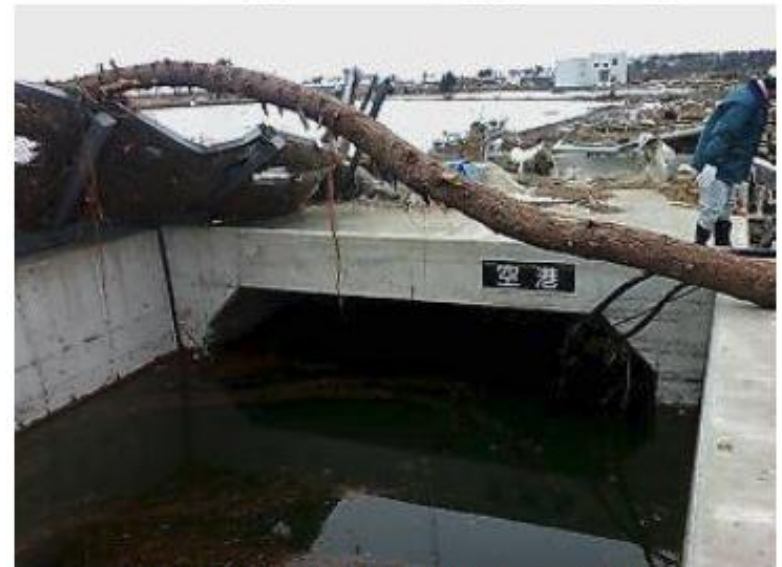
名取方面から空港トンネル入口
