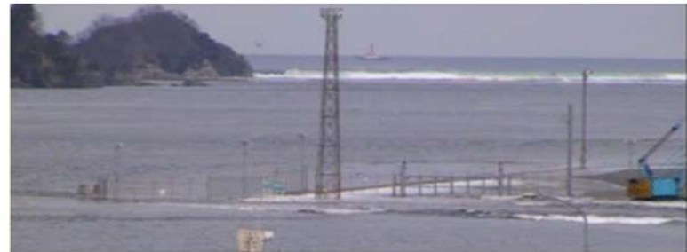
地震発生31分後：津波第1波が北堤を越流
