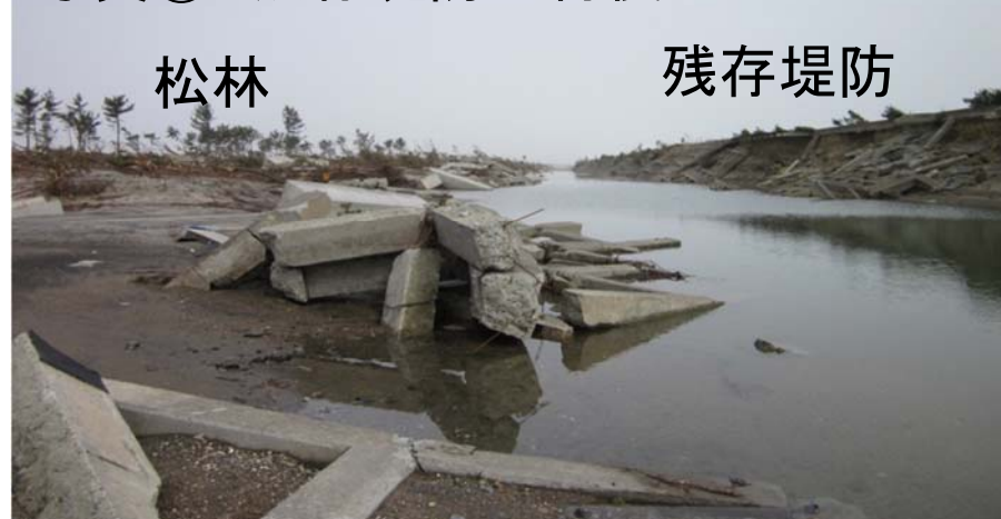
写真① 残存堤防の背後
