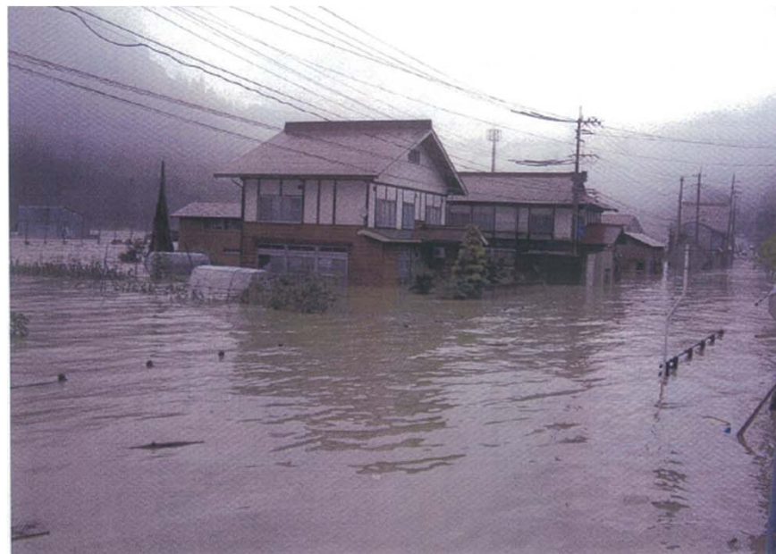
西谷地区浸水状況（7月30日未明）
