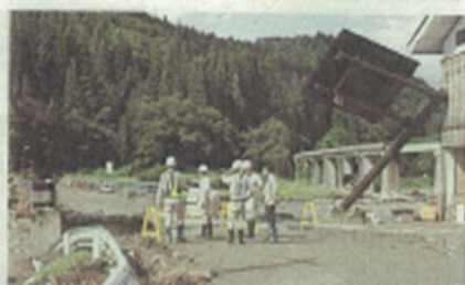
▲堅盤橋(叶津地区)
