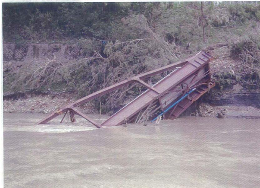
町道西部橋流失 (7月30日)
