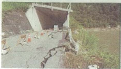
▲国道252号塩沢スノーシェッド付近
