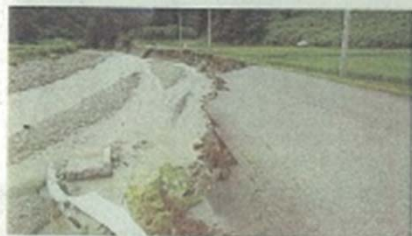
▲町道「小林塩ノ尻線」(塩ノ尻地区)
