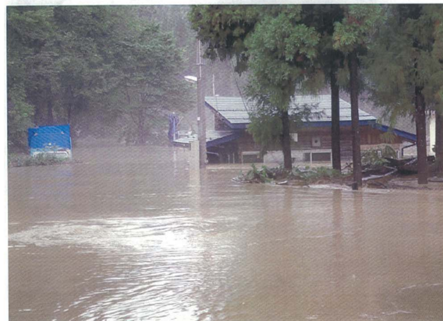
JR只見線会津水沼駅浸水状況（7月30日）
