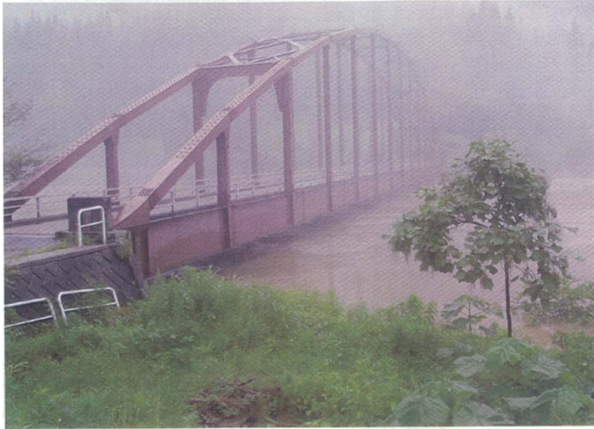
町道西部橋流失前 (7月29日)
