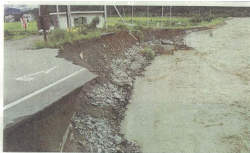
▲町道「御蔵前下4号線」(黒谷地区)
