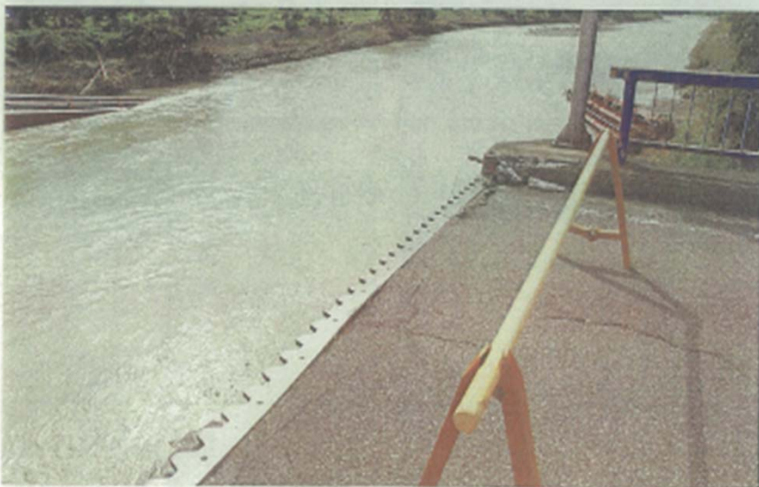
▲小川橋(小川地区)
