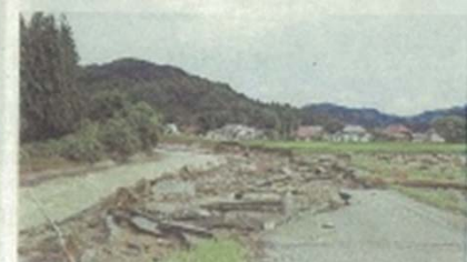
▲町道「関野土橋線」(小川地区)
