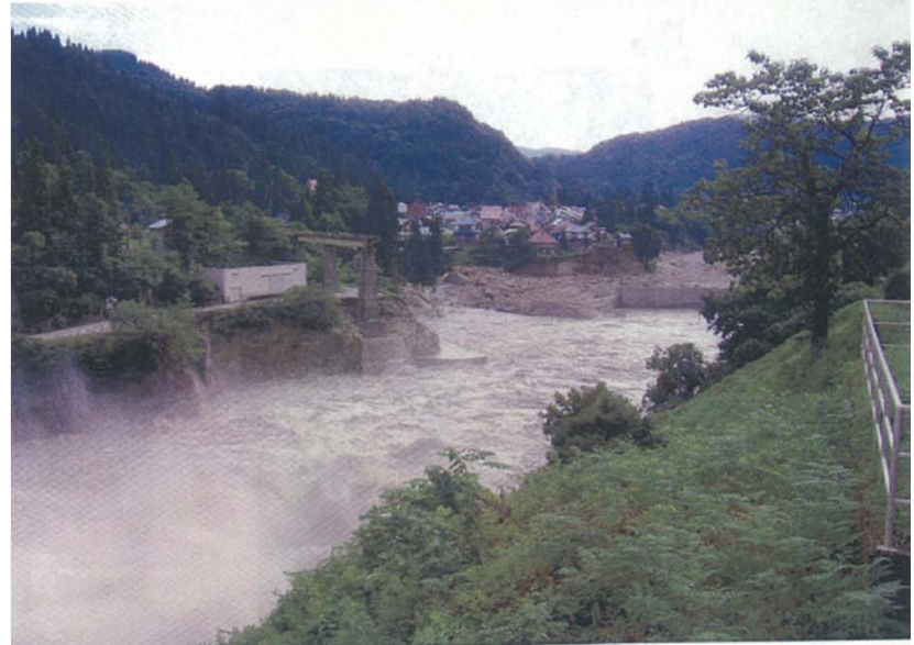
JR只見川第六鉄橋流失 本各地区堤防決壊 (7月30日)
