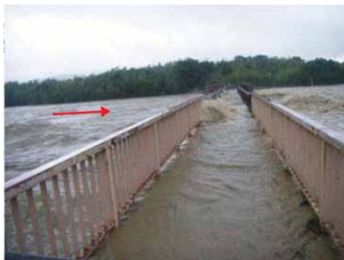
おおどめ 大留橋の状況
