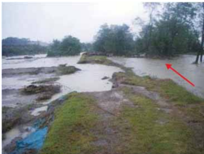
しもしだみ 庄内川(下志段味地区)の越水状況
