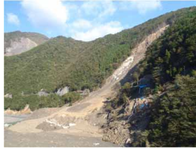
長殿発電所が増水により全壊した要因と考えられる土砂崩れ(10月27日、十津川村宇宮原(うみやはら)地区)
