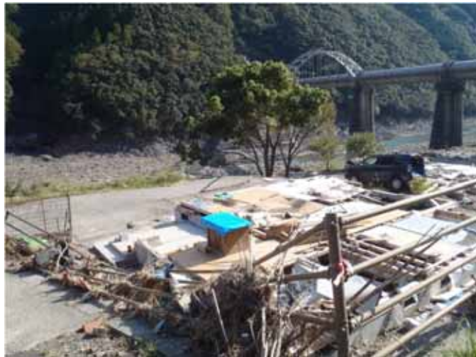
対岸の土砂崩れにより川の流が変わり押し流された村営住宅(10月27日、十津川村野尻地区(のじりちく))
