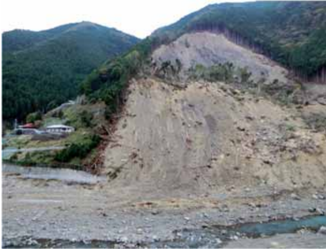
崩壊土砂は熊野川を越えて対岸の旧国道、集落に到達 (10月26日、五條市大塔町宇井(おおとうちょうい))
