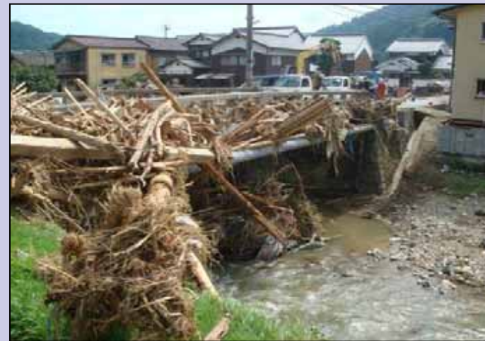
橋梁で流木が捕捉(平福地区)
