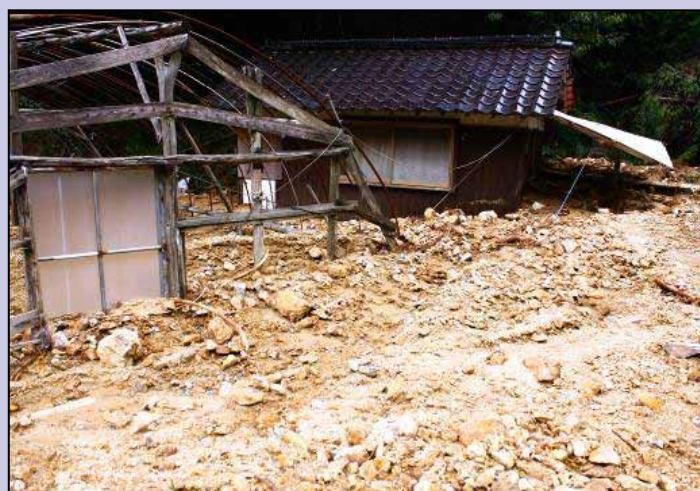
土砂による家屋被害 (海内地区)
