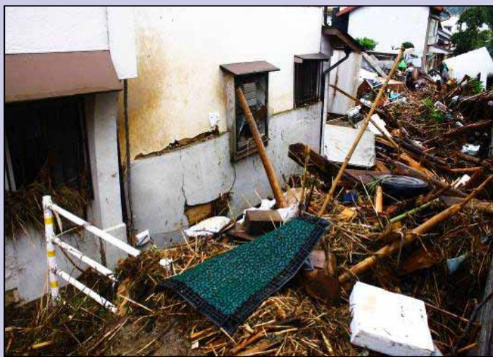
河川漂流物による家屋被害 (佐用地区)
